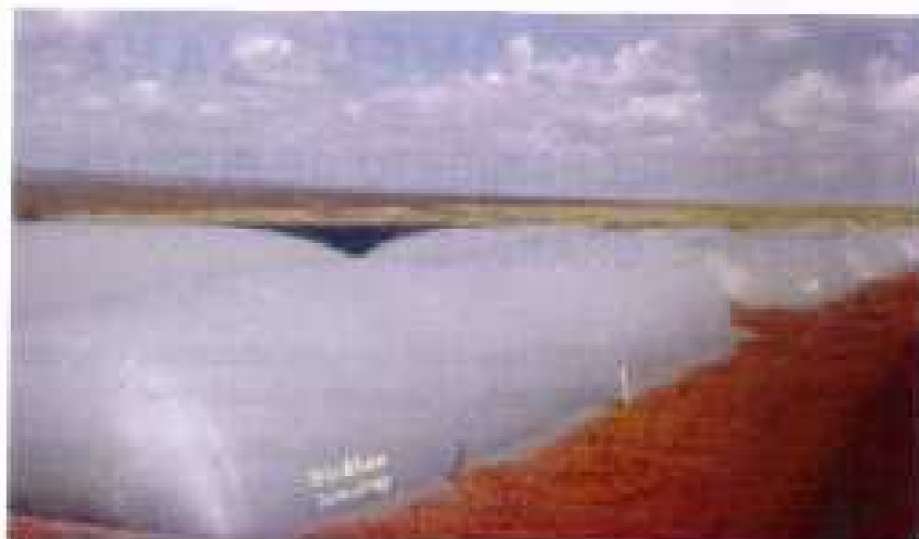
BIODIGESTOR ANAERÓBICO EN GRANJA VACUNA EN SANTA CATARINA (BRASIL) CORTESÍA DE BIOGÁS MÉXICO
