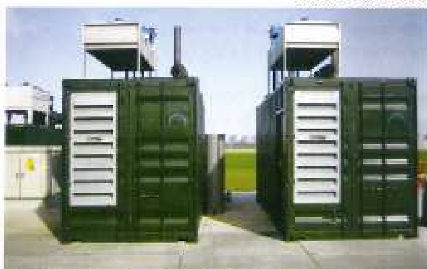
MOTORES PARA PRODUCCIÓN ELÉCTRICA Y TÉRMICA A PARTIR DE BIOGÁS EN UNA GRANJA VACUNA.
