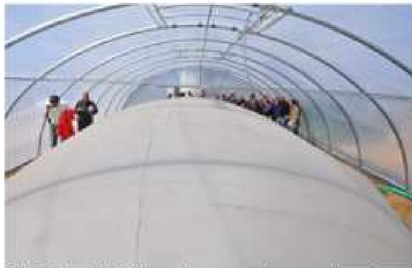
Detalle del interior del invernadero, necesario para acelerar el proceso anaeróbico bajo condiciones de frío intenso.
