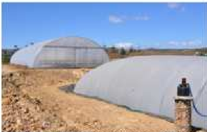
Detalle de biodigestor cubierto (uso invierno) y descubierto (uso verano) en granja avícola de Portugal.
